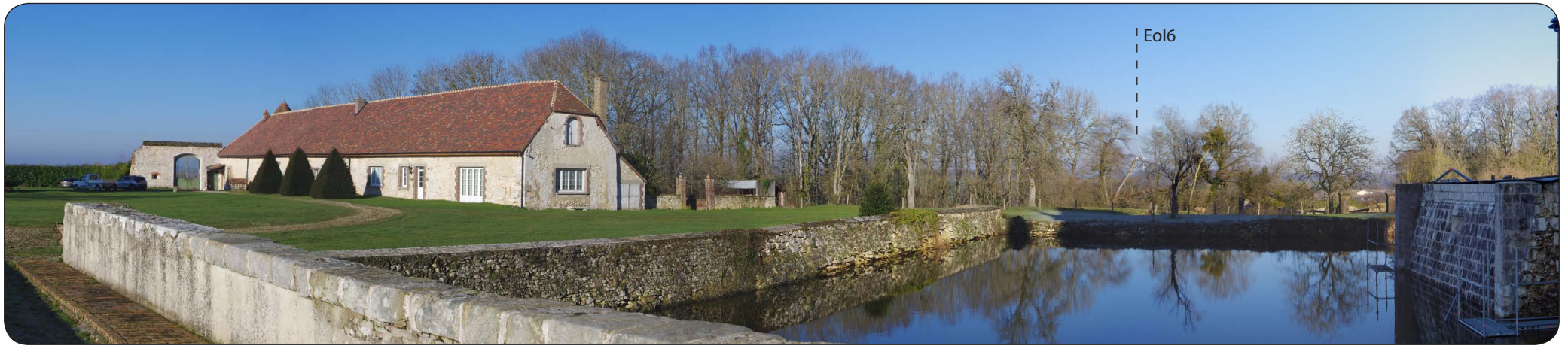
Panoramique PE001 - Château d'Esternay - Depuis le pont enjambant les douves
